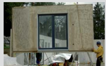
Woche 20 Im Anflug: Das erste Fassadenelement wird montiert.
