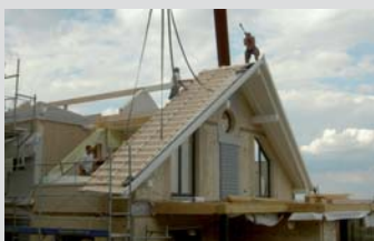
Woche 20 Aufrichte: Auch der Dachstock ist fertig vorproduziert.
