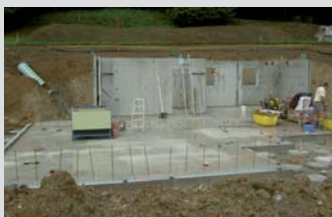
Woche 16 Fundament: Grundplatte und Kellergeschoss werden betoniert.
