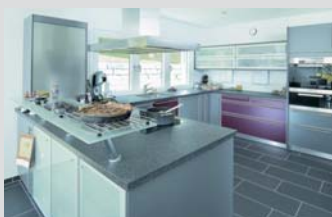
Wochen 21–32 Innenleben: Handwerker installieren die Innenausstattung.
