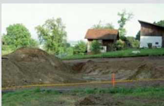
Woche 15 Aushub: Platz schaffen für das neue Haus.
