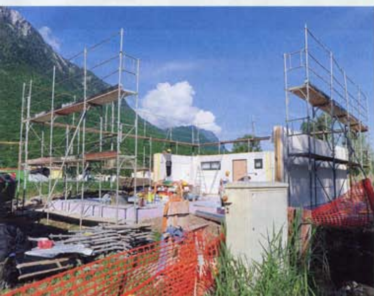
8 H 42 Les murs sont directement posés avec portes, fenêtres et stores. Même la chaudière sera incluse dans l'une des parois!
