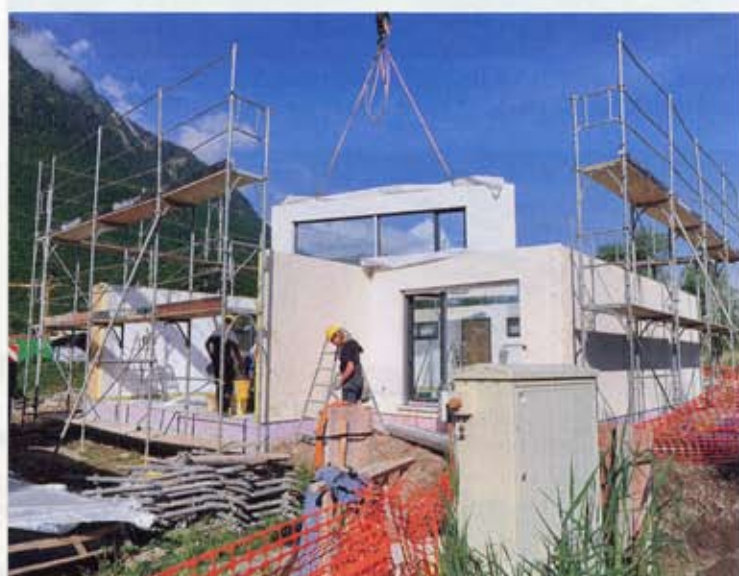
9 H 10 Chaque mur est amené par grue, tiré de camions venus d'Allemagne. Les ouvriers, eux, sont d'une maison thurgovienne.
