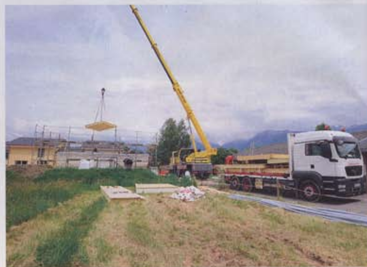
Fin de construction imminente. La grue et le dernier camion chargé des éléments de la maison vont quitter le chantier.
