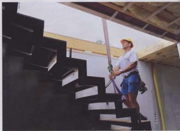
A peine le plancher de l'étage est-il en place que l'escalier arrive, d'une pièce, déposé par la grue.
