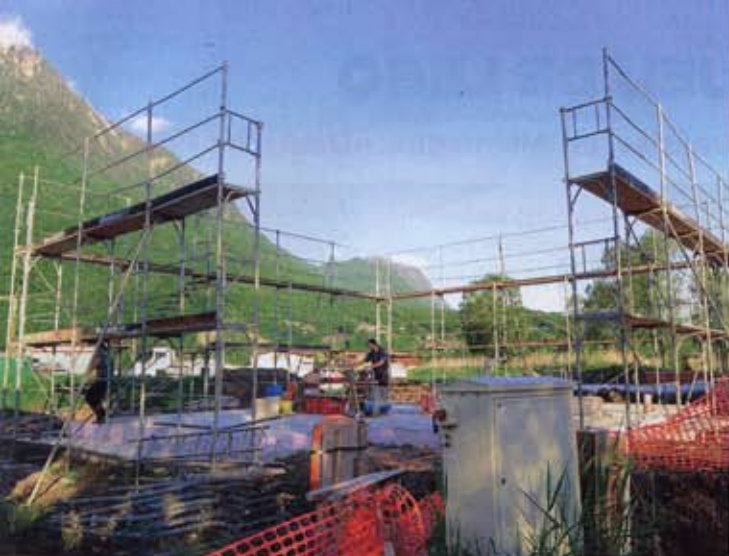
1 er JUIN, 6 H 55 La construction commence. Il n'y a encore que le radier (dalle en béton), posé dans les jours précédents.
