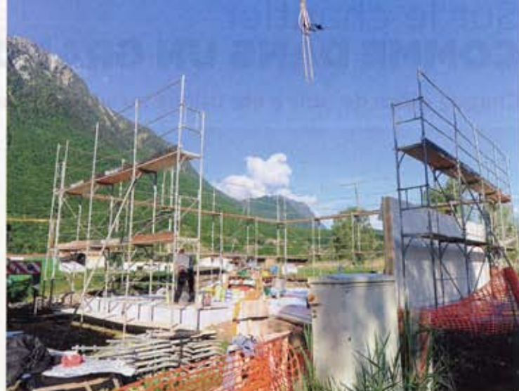
8 H 18 Les premiers murs du rez s'emboîtent et se fixent au sol. Cette partie droite de la maison abritera le bureau de Bertrand.
